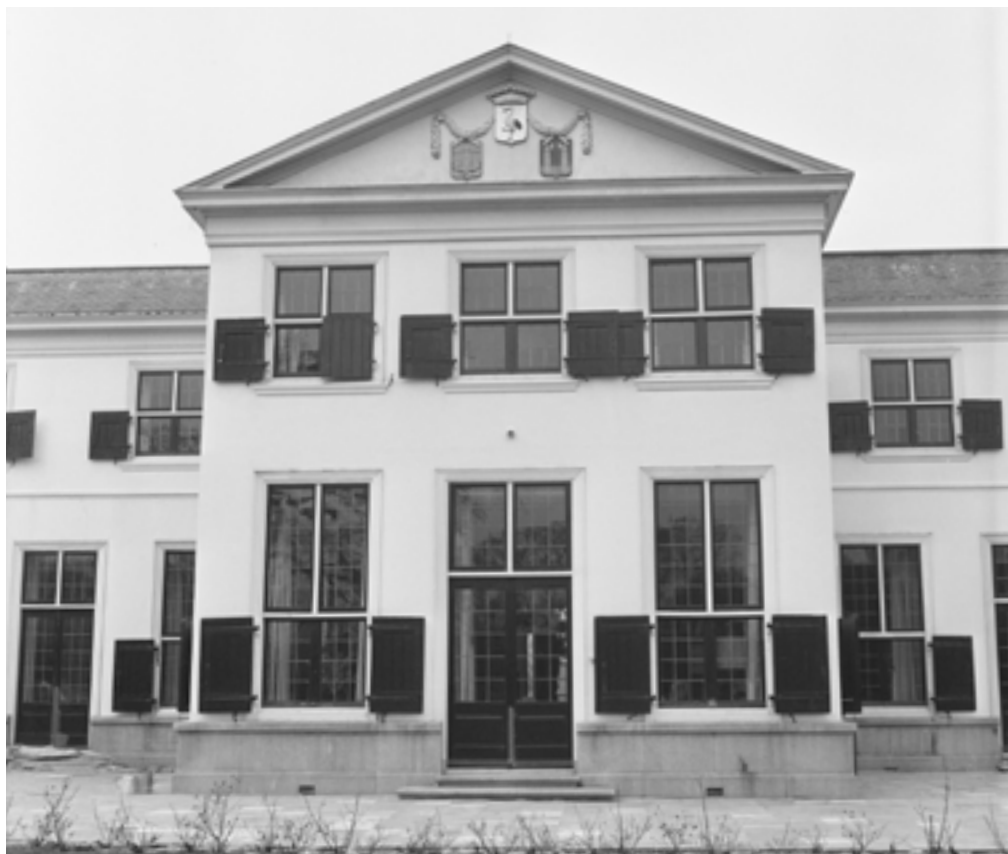
Afb. 17 Detail middenstuk achtergevel in 1964. fotograaf J. Smulders, gaHetNA 2.24.01.03_0_916-1038
