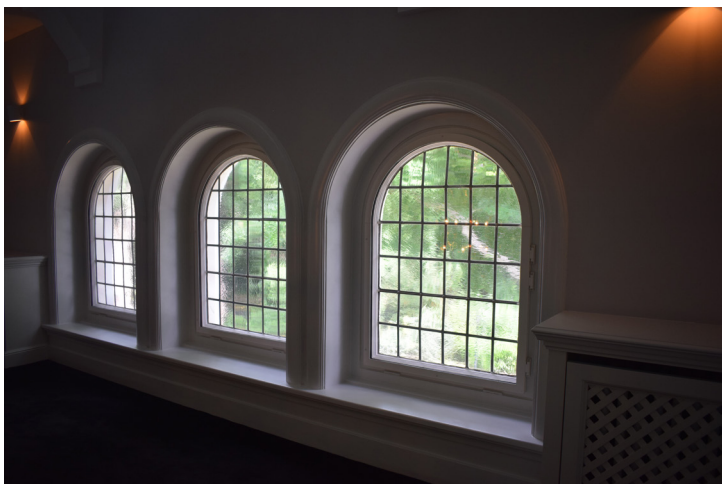
Daglichttoetreding op de verloop in het trappenhuis
