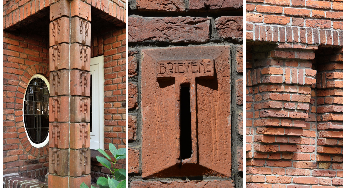
Details van metselwerk.
