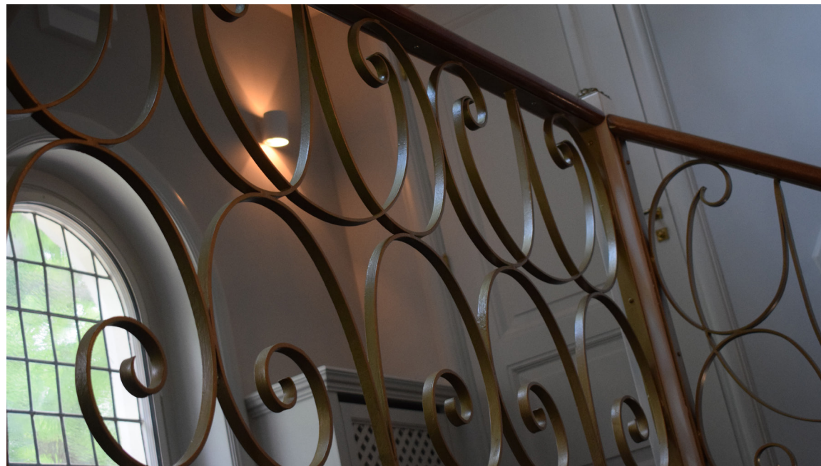
Het hekwerk in het trappenhuis
