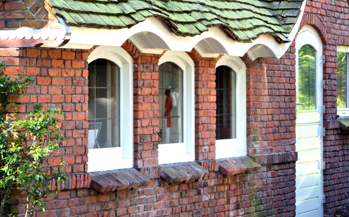
Detail van de gevel van Schouwweg 103
